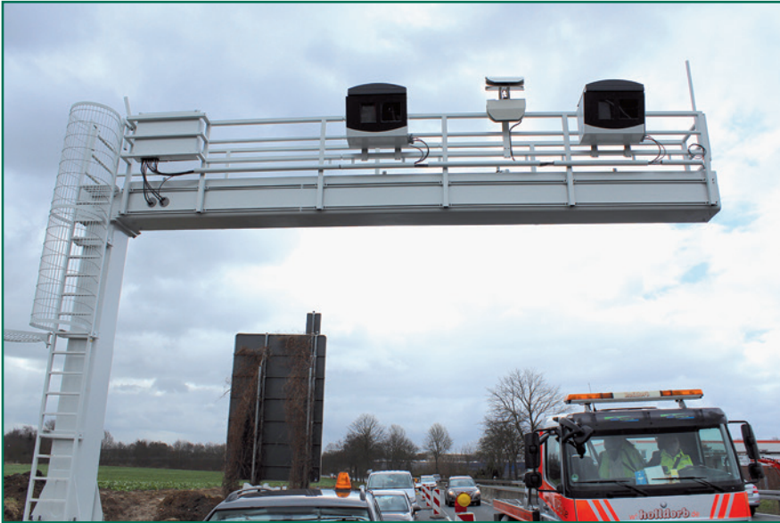
Niedersächsische Pilotstrecke: die zweispurige Bundesstraße 6, südlich von Hannover, zwischen Gleidingen und Laatzen mit einem Streckenabschnitt von 2,1 Kilometern Länge. Foto: Sebastian Denecke/GdP
