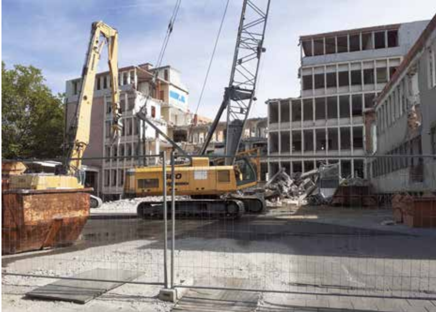
Die Abrissmaschinen erfüllen ihre Pflicht an dem in die Jahre gekommenen und letztlich nicht mehr nutzbaren Gebäude.
