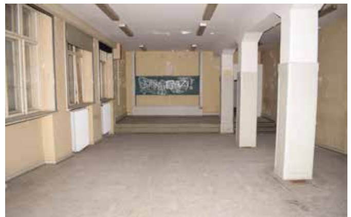
... und der Unterrichtsraum im Erdgeschoss
