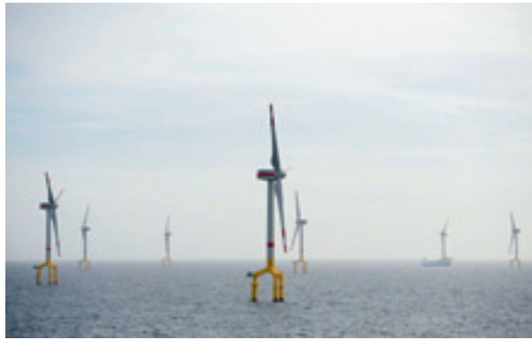
Der 100 km nordwestlich von Borkum gelegene Offshore-Windpark BARD Offshore wurde am 7. April 2011 als erster kommerzieller Nordsee-Windpark Deutschlands in Betrieb genommen. Ende kommenden Jahres sollen alle 80 Windräder installiert sein. Foto: Nigel Trebin/dpa
