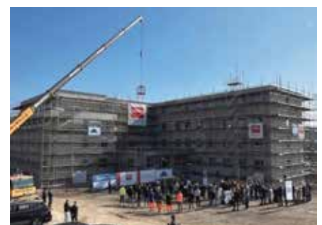
Der Rohbau beim Richtfest
