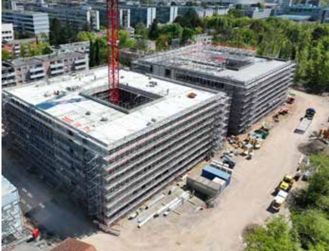
Die beiden Gebäudeteile im Rohbau
