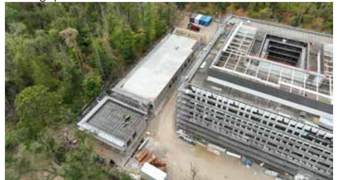
Am äußeren Ende befinden sich die Gebäude für die Diensthunde
