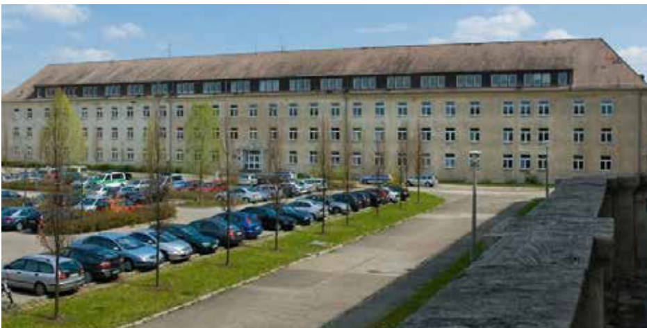
Dieses Gebäude in der ehem. Fliederweg-Kaserne in Halle soll durch einen Neubau ersetzt werden.
