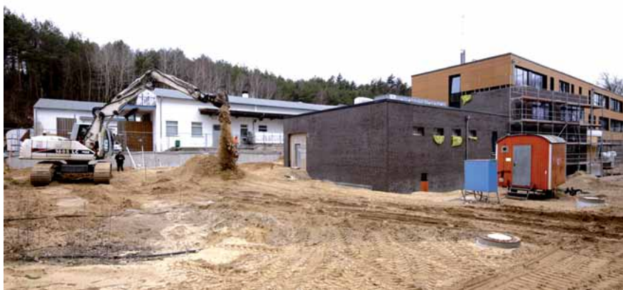
Neubau Polizeirevier Heringsdorf – Blick auf die Baustelle
