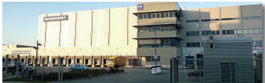
Das Hochregallager in Allermöhe
