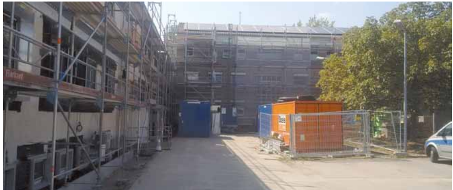
Außenaufnahme: Modernisierungsmaßnahmen COME (energetische Gebäudesanierung) bei der Polizeidirektion Bergstraße
