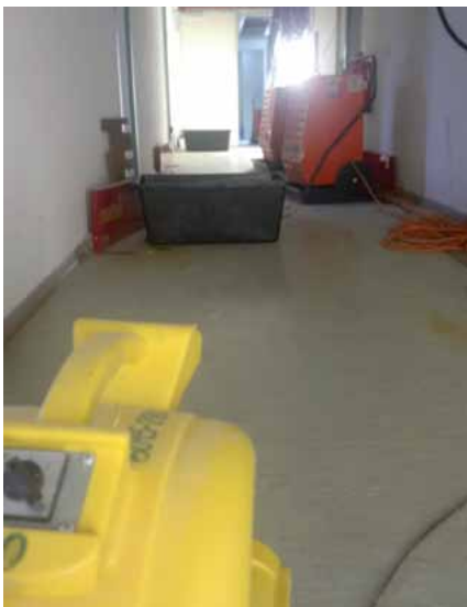
Innenaufnahme: Modernisierung im laufenden Betrieb
