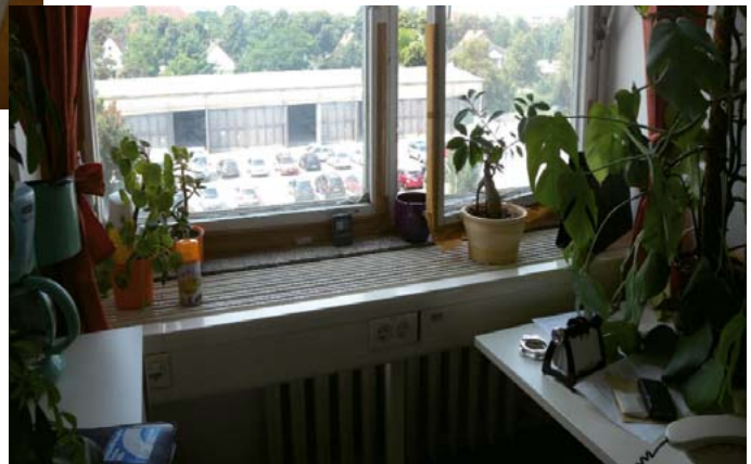
Fensterabdichtung mal anders. Haben wir doch gelernt – Improvisation und Selbsthilfe ist alles. Fotos: Kreisgruppe OHV
