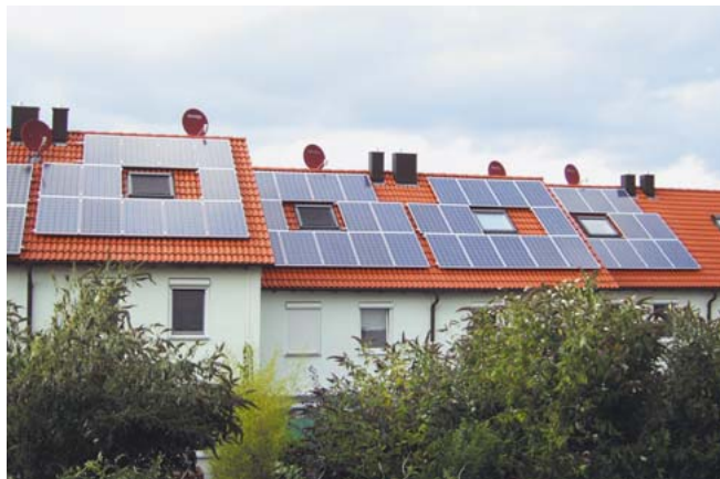
„... im Schulterchluss mit den angrenzenden Nachbarn von Reihenhäusern. Überall im Land wurden die GdP-Photovoltaik-Anlagen montiert.“
