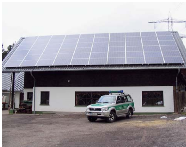
Das „Kraftwerk am Schluchsee“
