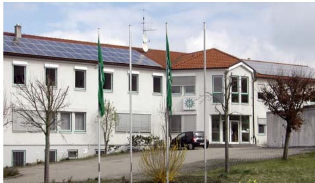
GdP-Geschäftsstelle Eberdingen mit der montierten Photovoltaik-Anlage.
