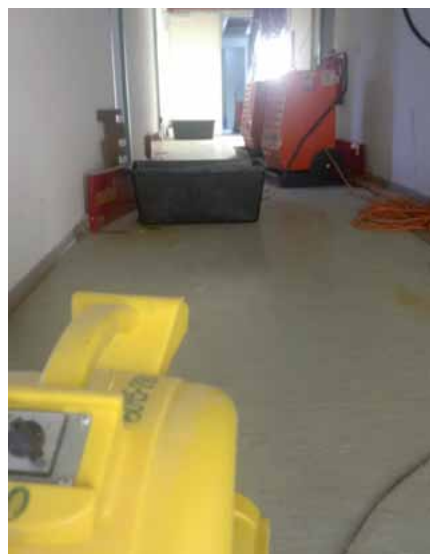
Innenaufnahme: Modernisierung im laufenden Betrieb
