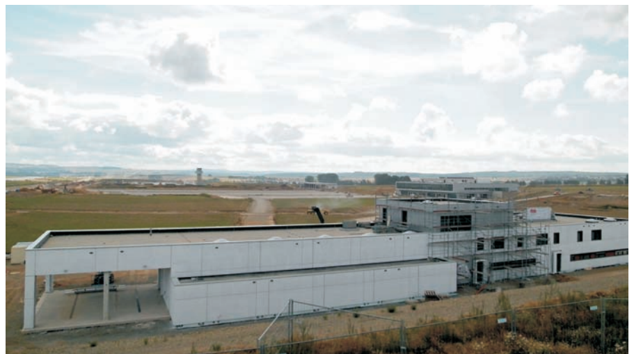
Flugplatz Kassel-Calden, Europas größte Erdbaustelle (Foto: Gerland)
