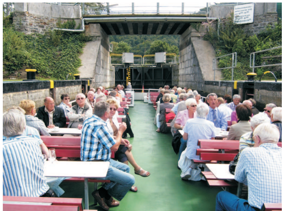
In der Schleuse
