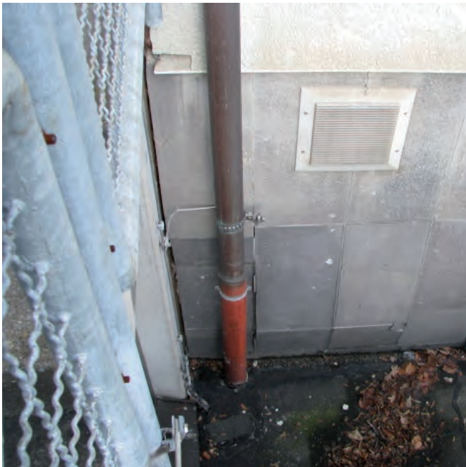
Foto links: Riss in der Fassade im Hof und darunter abstehende Platten (Präsidium).
