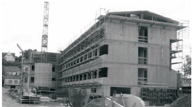
Das neue Gebäude im Rohbau.
