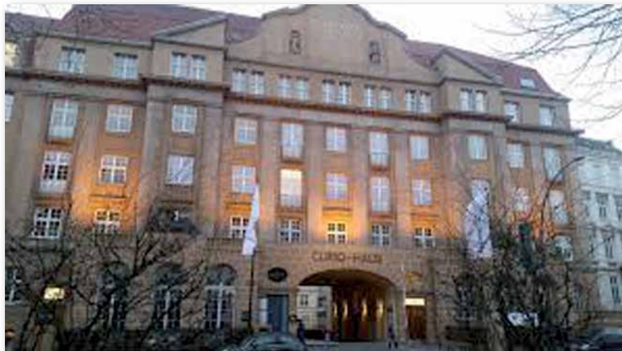
Das Curio-Haus in Hamburg-Rotherbaum
