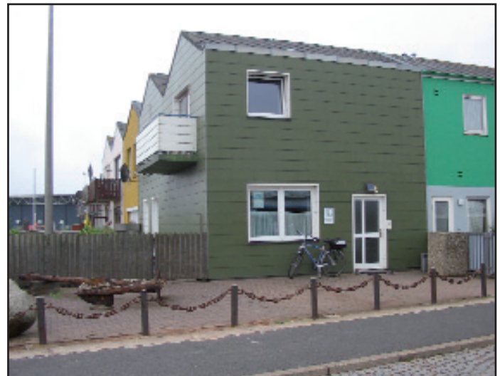
Dienstgebäude auf Helgoland
