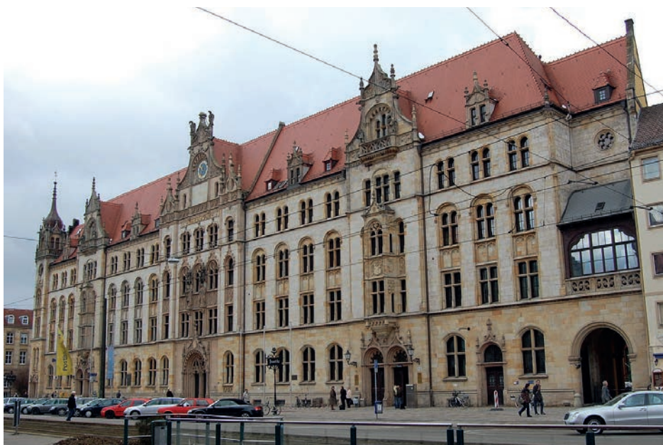
Das Magdeburger Verwaltungsgericht mit Sicht auf den Fronteingang (Breiter Weg 203)
