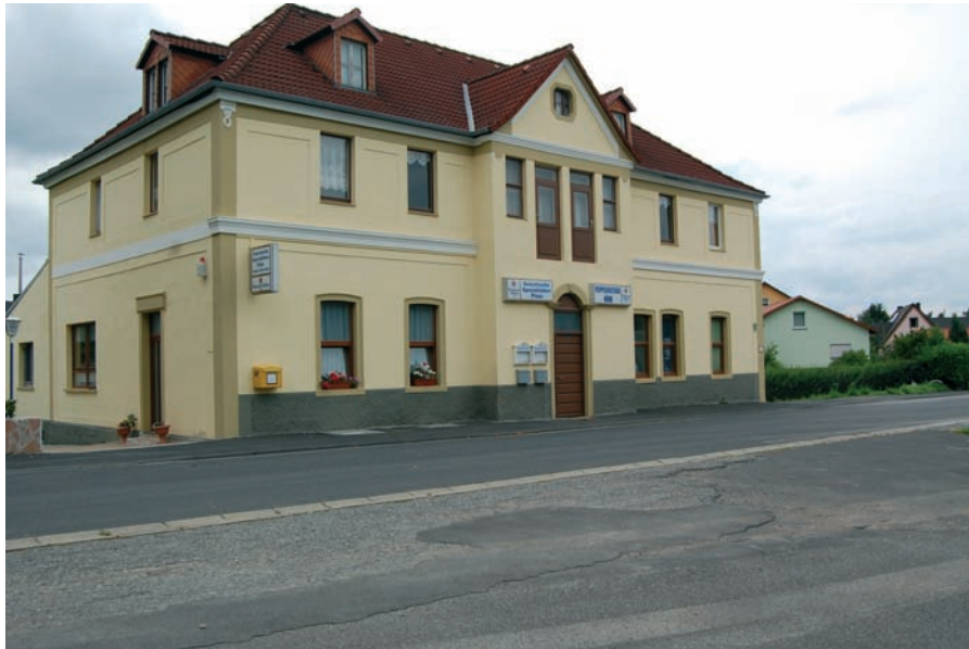
In diesem Gebäude war einst der Polizeiposten im ersten Obergeschoß untergebracht
