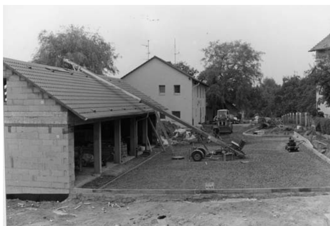
Der Beginn. Das Anwesen „Alte Heerstraße 3“ wird für die Polizei umgebaut.
