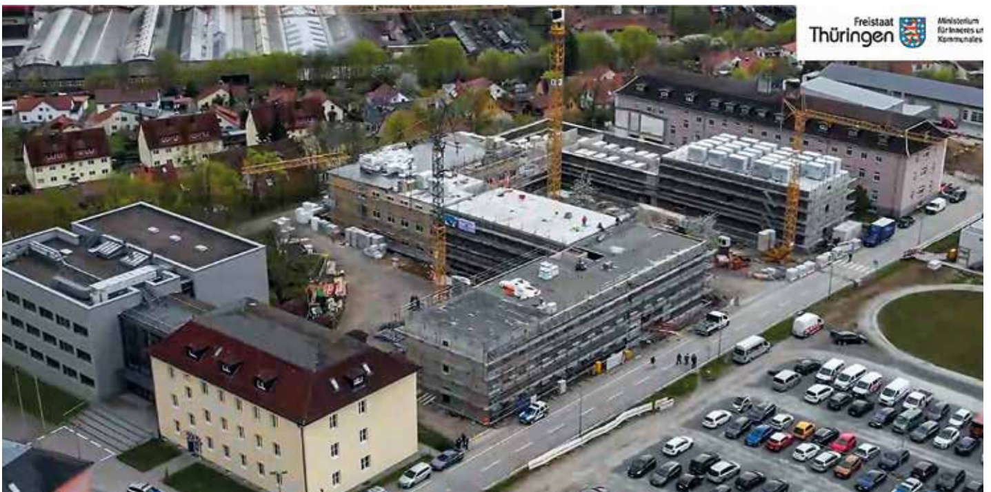
Das neue Unterkunftsgebäude aus der Vogelperspektive
