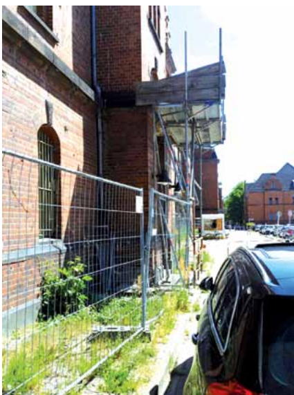
Die Zulassungsstelle Jüterboger Straße präsentiert sich seit Ewigkeiten in schönem Baustellengewand.
