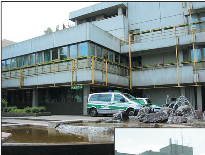
Gebäude der PI Lebach
